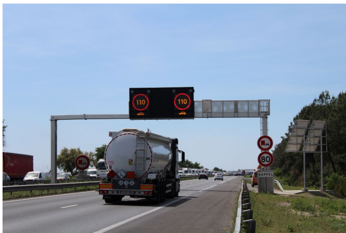
Panneaux de vitesse variable en section courante
